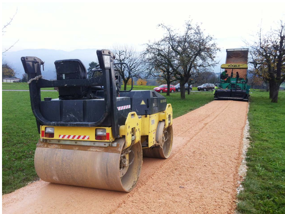
Neubau eines Weges in der Gesamtmelioration Blauen.
