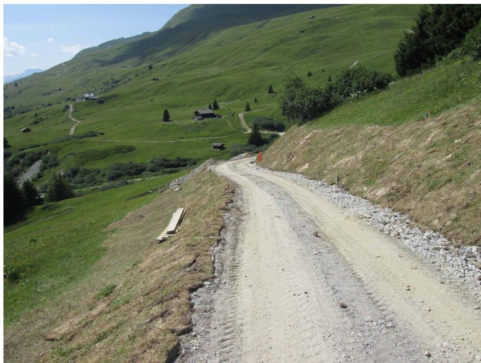
Die fertig begrünte Böschung direkt nach Abschluss der Bauarbeiten.
