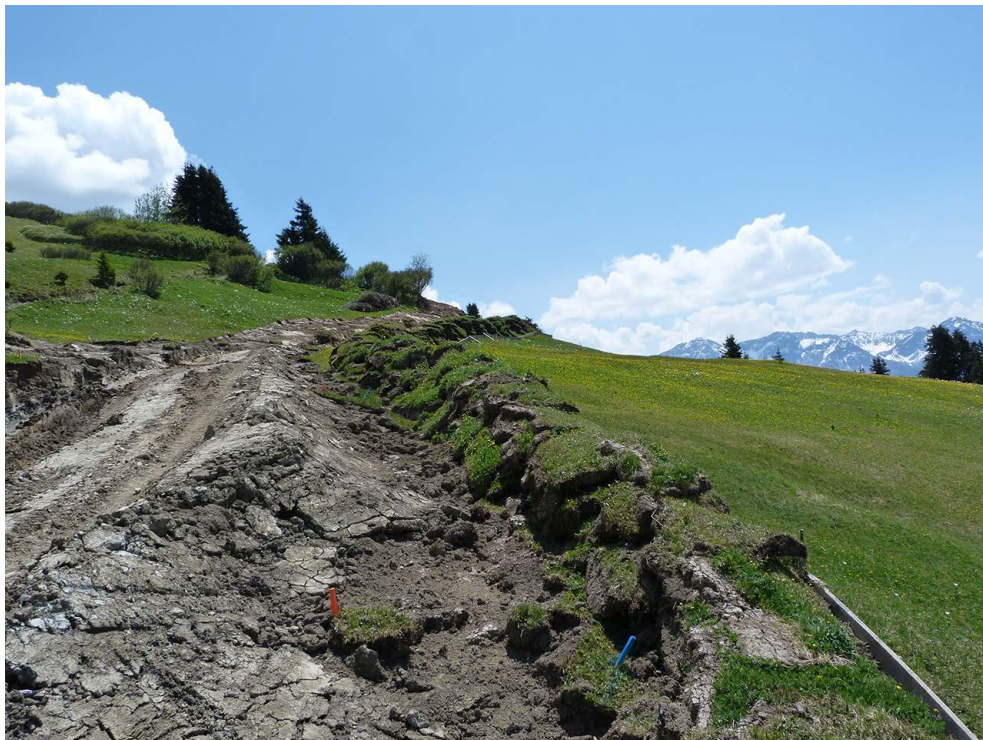
Die Deponie der Rasenziegel erfolgt über die ganze Weglänge verteilt im Schwenkbereich des Aushubgeräts.
